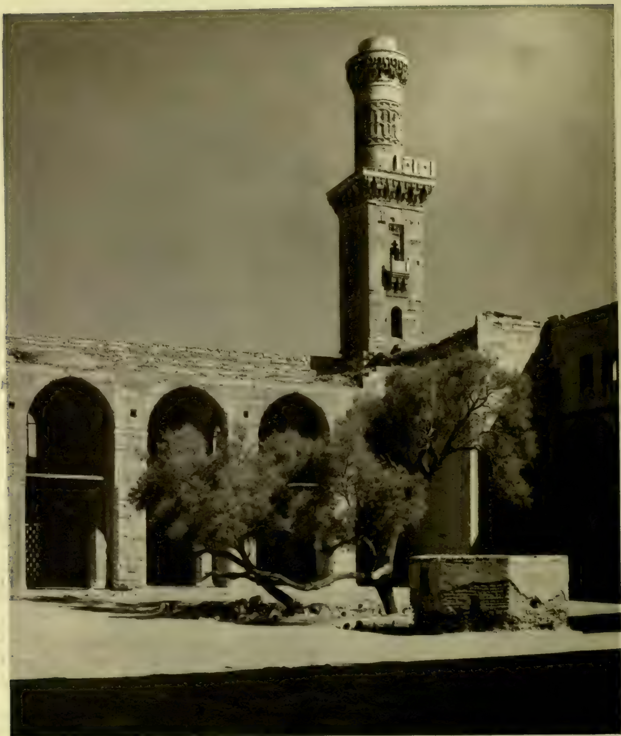
Kairo. Hof im Grabbau des Barqūq.
