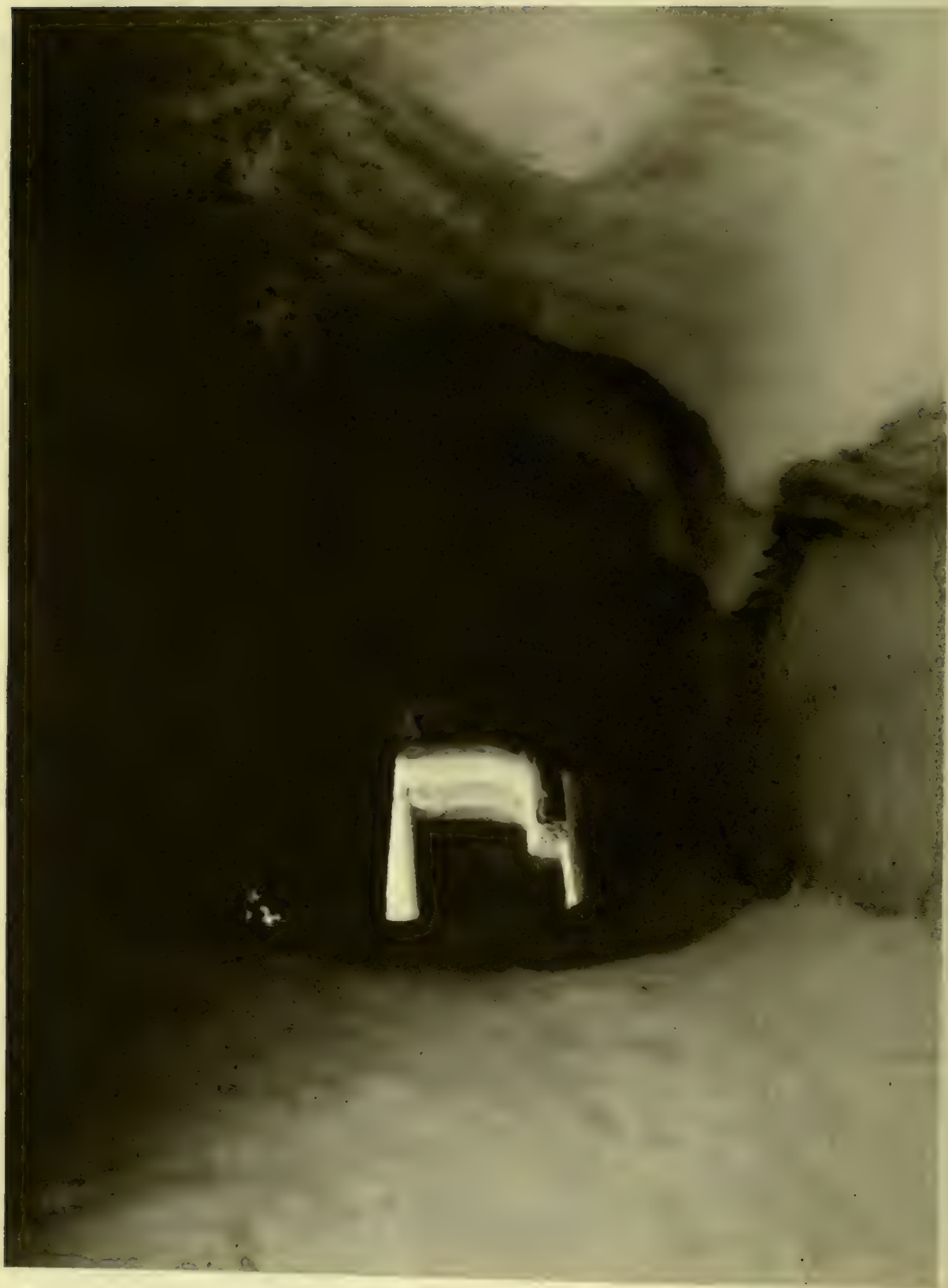
Oase Charge. Überbaute Straße im Hauptort.
